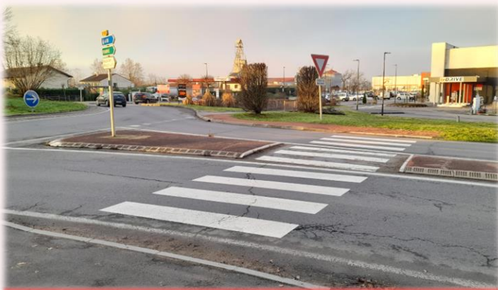
Création d'un passage piéton protégé sur la RD 1082 pour rejoindre la zone d'Intermarché depuis le côté de La Noaille.
